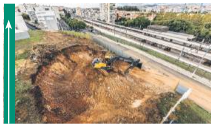
Arranque da construção de 50 apartamentos junto à Residência Universitária de Benfica
