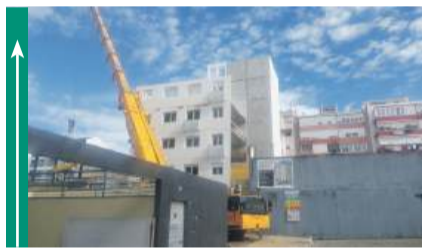
Avança a bom ritmo construção modular nas traseiras da Av. Gomes Pereira
